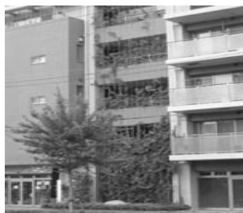
町田市某マンション壁面緑化
