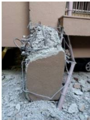
I-② 破断した柱
