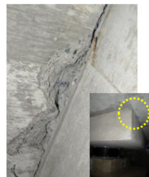
V-1-④ 外階段下積層ゴム支承上側の取付け基部損傷
