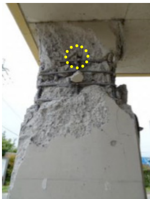
Ⅱ-2-②、Ⅱ-2-③ 梁主筋または2階柱主筋の定着部
