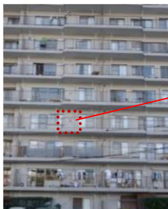
←Ⅲ-1-① せん断破壊(1~7階)
