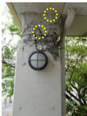
Ⅱ-2-②、Ⅱ-2-③ 梁主筋または2階柱主筋の定着部
