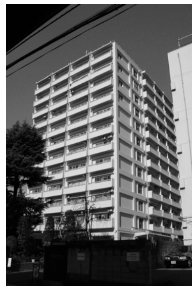
Fマンション全景
