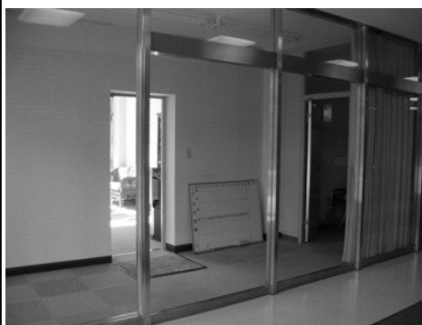
エントランス改修:非構造体間仕切り壁を構造壁に改修
