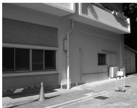
外壁:改修外壁の増し打ち壁(右側の壁)
